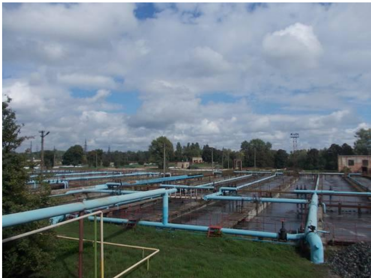
Очисні споруди КП «Чернігівський водоканал»
